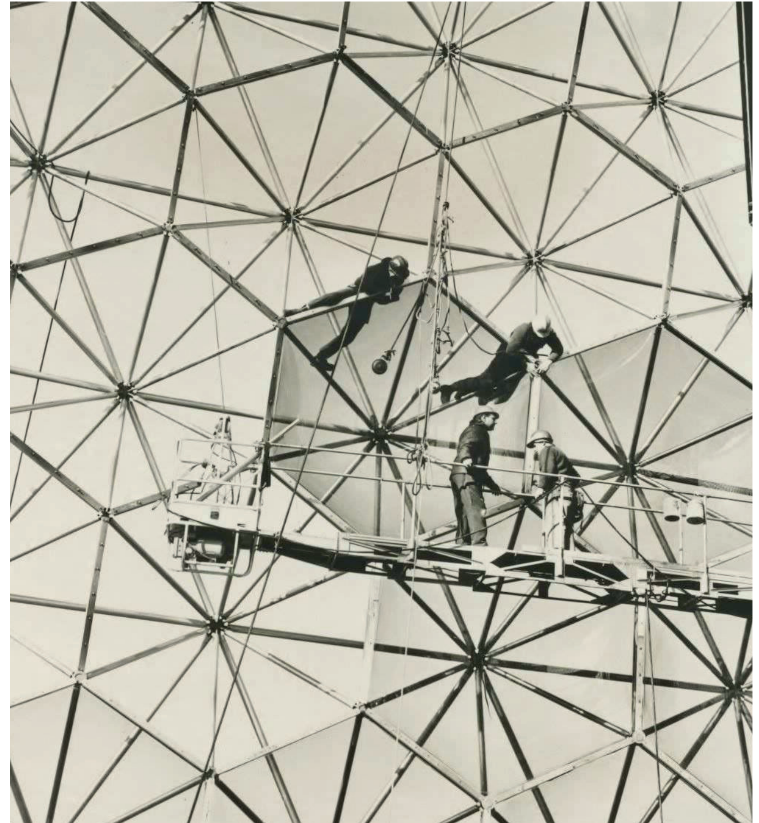
Installation d'un panneau acrylique pour l'Expo 67. (DC Hillier's MCM Daily - Bucky's bubble, 2016)
