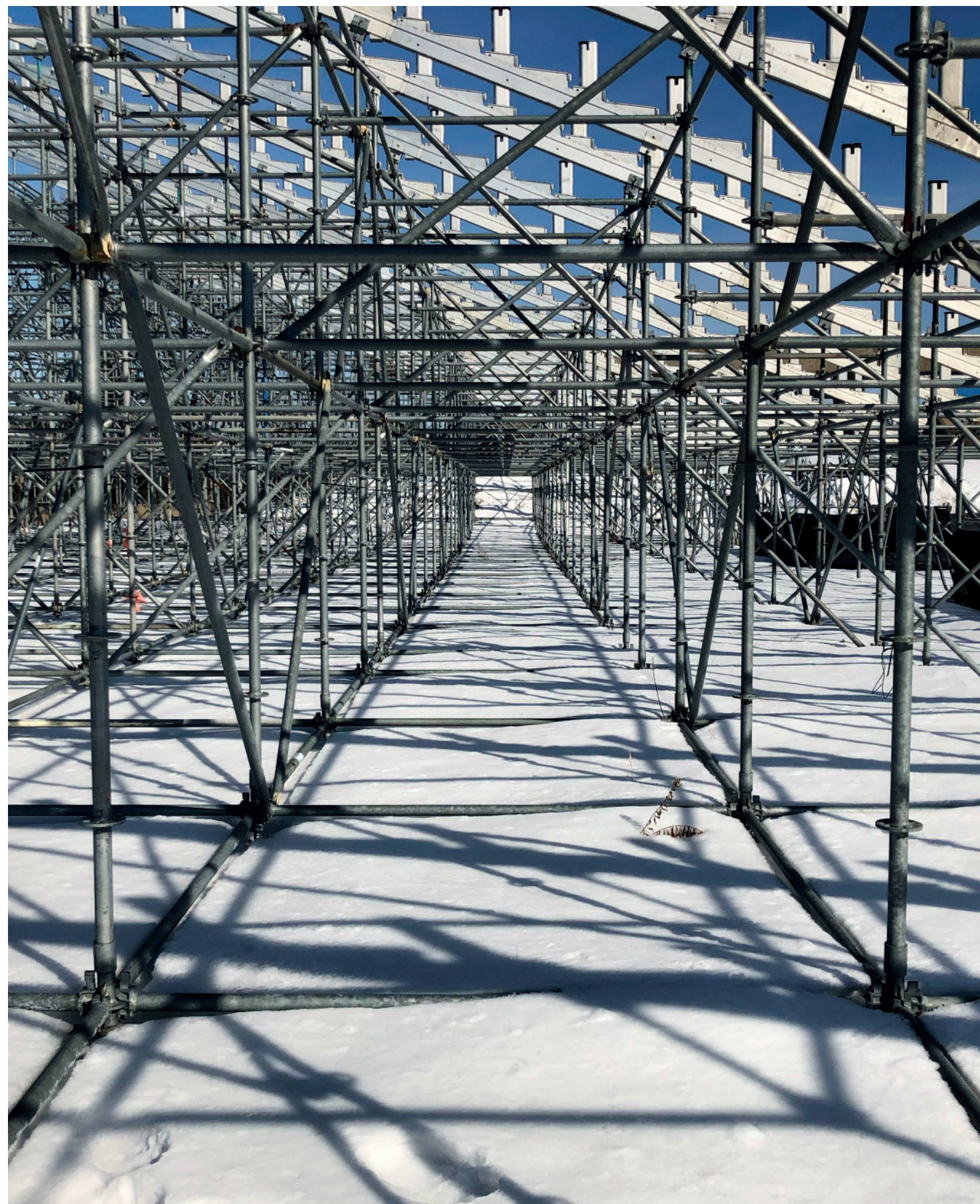
Photographie à l'intérieur des échafaudages du circuit Gilles Villeneuve Par Mahdi Namir
