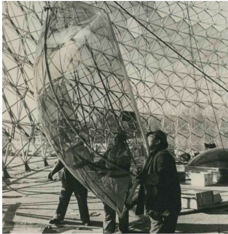
Installation d'un panneau acrylique pour l'Expo 67. (DC Hillier's MCM Daily - Bucky's bubble, 2016)
