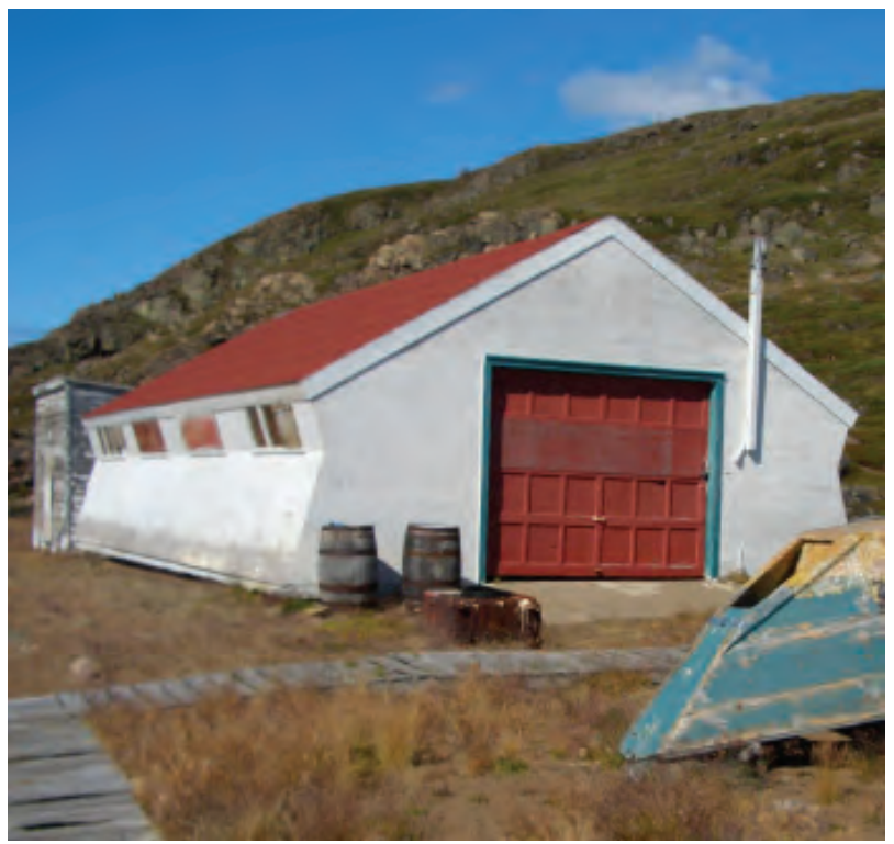
Hangar à bateaux construit selon les angles traditionnels, ce qui permet d'intégrer les déflecteurs à vents dans l'architecture du bâtiment.
