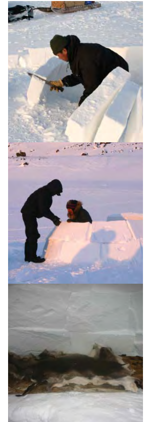
Construction et isolation interne de l'igloo | source: http://getoutradio.com/?p=83
