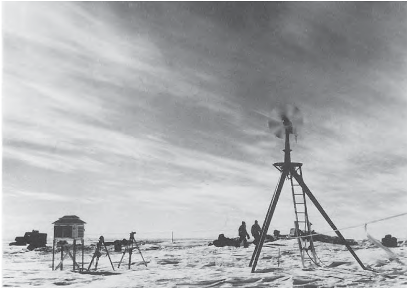
Éolienne aéro watt à la station Charcot alimentant une station météo des Expéditions Polaires Françaises | source: http://eolienne.cavey.org/html_fr/prototypes.php
