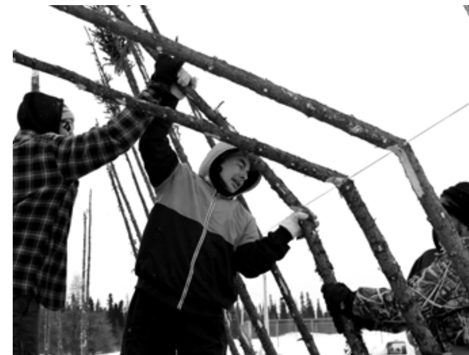
Perches pliées vers l'intérieur de la structure
